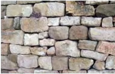
Die Neuanlage von Trockenmauern ist eine im Ökokonto anrechenbare Naturschutzmaßnahme.
